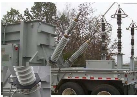
Slika 10: Tuljava Rogowski okrog izvoda na mobilni RTP (razdelilni transformacijski postaji) [5]
