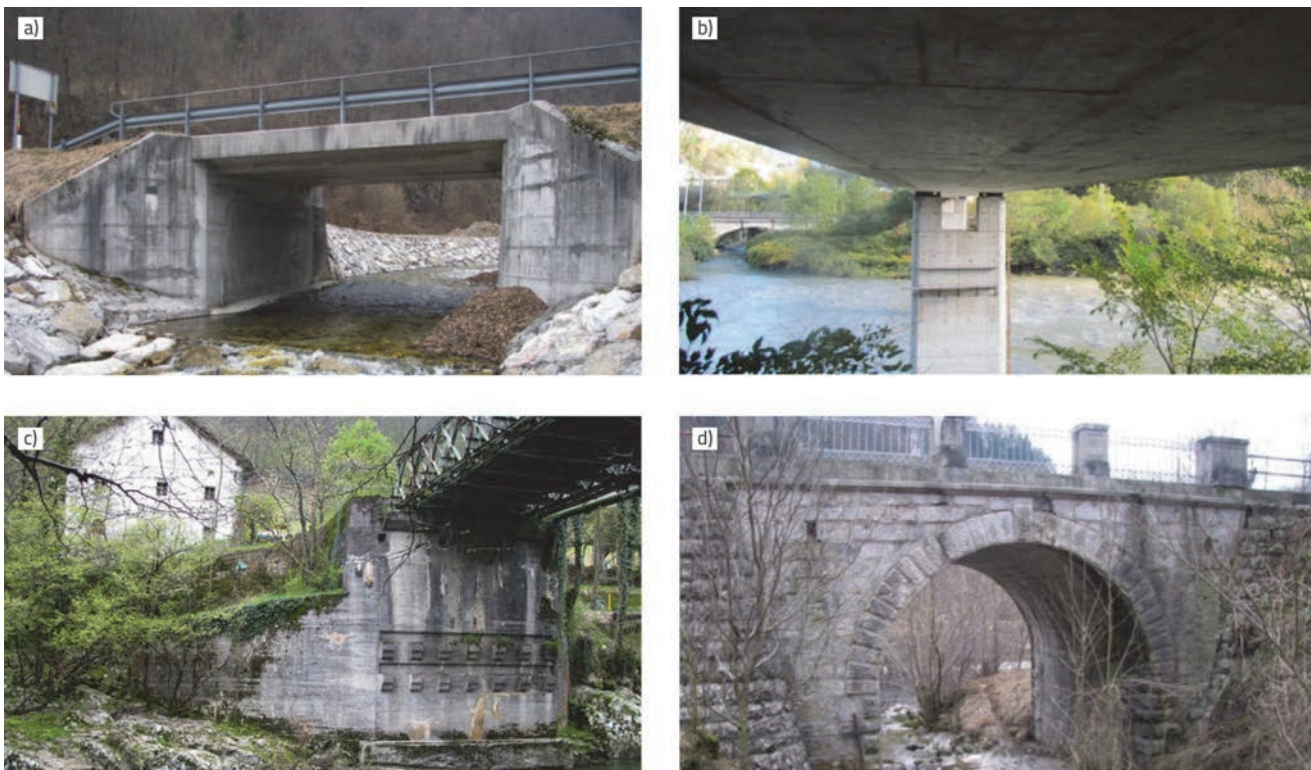
Slika 4. Primjeri mostova: a) armiranobetonski; b) prednapeti; c) čelični; d) kameni. Kod primjera a), b) i c) donji ustroj je izgrađen od betona, a kod d) od kamena
