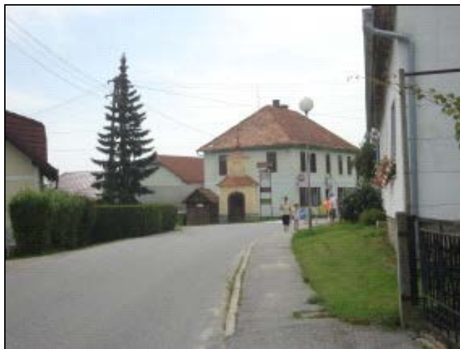
Slika 9: Kapelica, posvečena neznanemu svetniku in potrebna temeljite obnove
