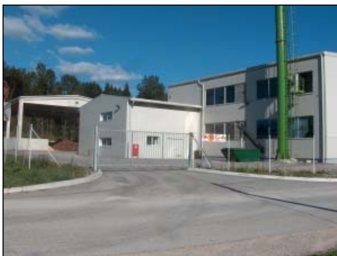
Slika 10: Kotlovnica v Kočevju (Vzdrževanje ..., 2011)
