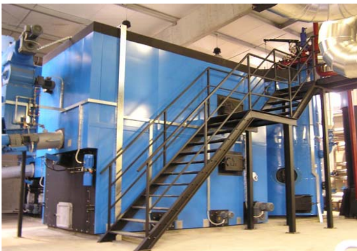
Slika 8: Prikaz kurilne naprave z kotlom poleg kurišča kurilne naprave.
