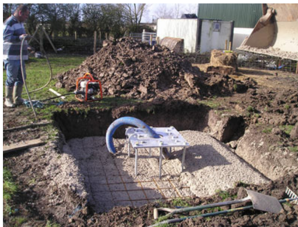
Slika 15: Izgradnja temelja za vetrni generator (Aeolus Power, 2007)
