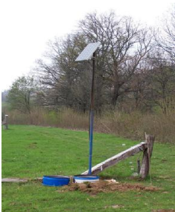
Slika 3: Pašni aparat spravljen v zaklenjenem sodu in sončni pano na visokem drogu, tako da sta varna pred tatovi (foto: M. Vidrih)
