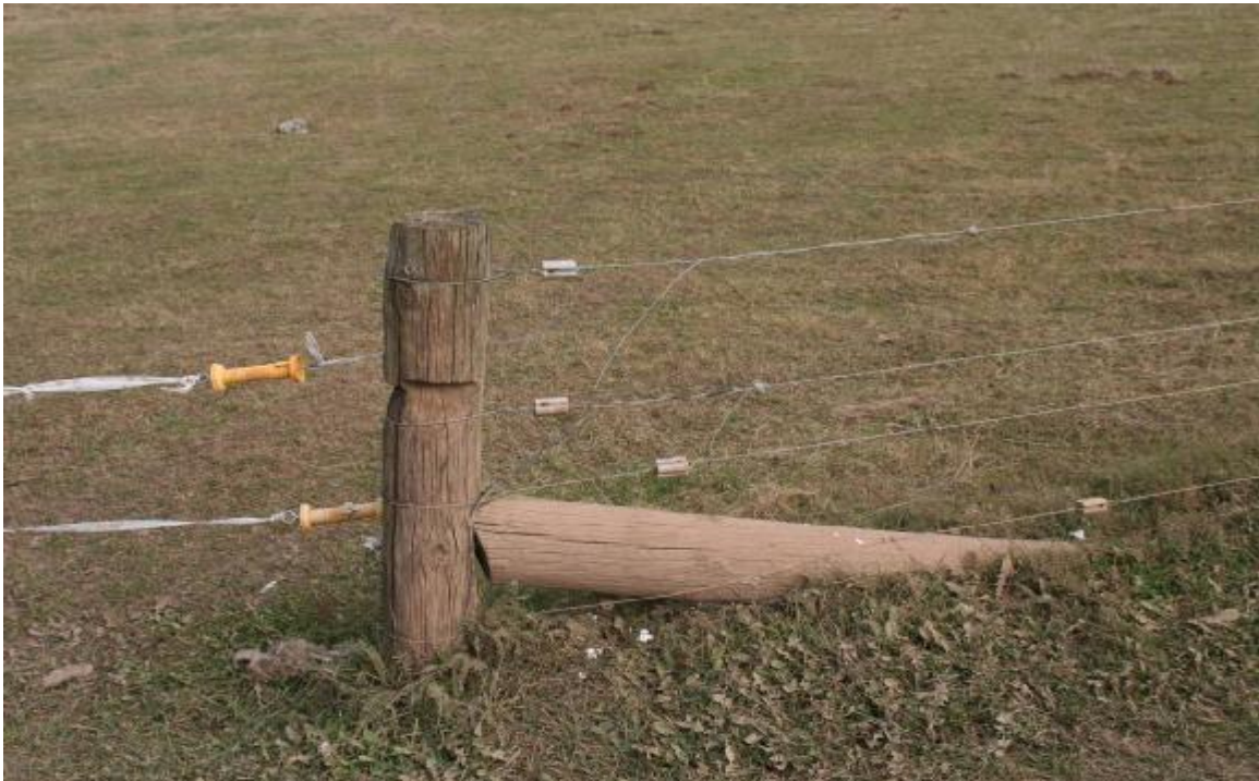
Slika 1: Pravilna postavitev začetnega kola in opora (foto: D. Saftič)
